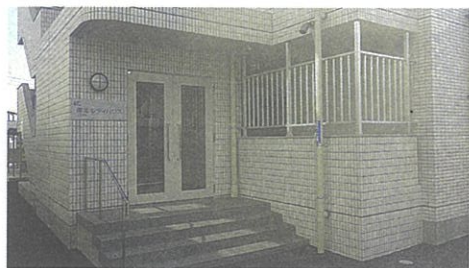
4基建がかさ上げされたバルコニー(大進建設提供)
